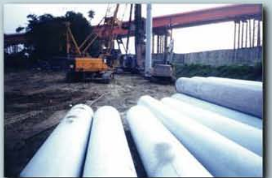
▲PC樁施工現場
