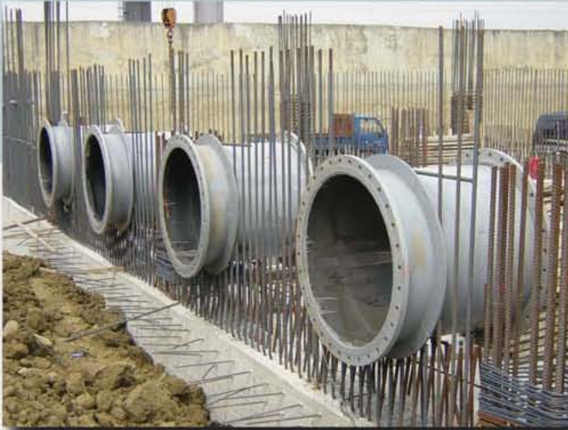
▲穿牆管預埋施工
