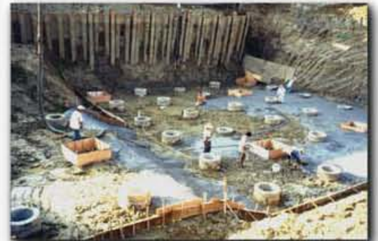
▲PC樁施工後
