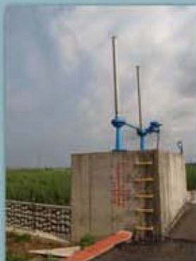
▲排水道及閘門
