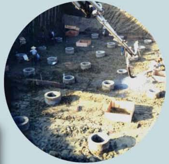
▲PC樁施工後
