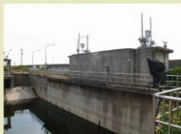
▲調節池及排水閘門
